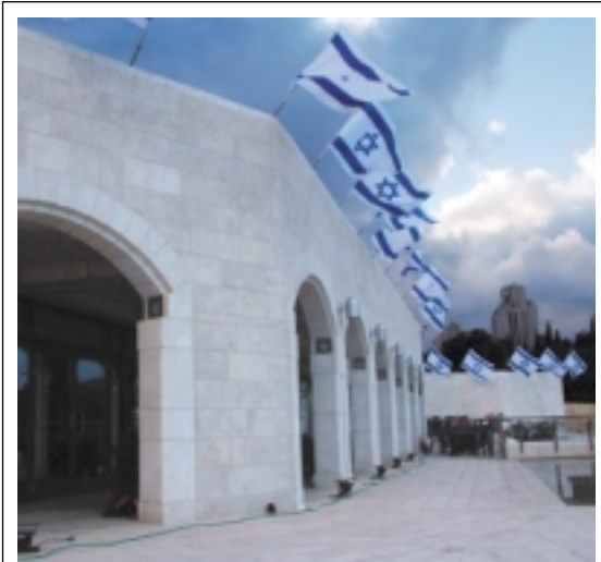
Das Heritaz Center fungiert nicht nur als Museum, sondern auch als Bibliothek, Ausbildungs- und Forschungszentrum. Hier befindet sich der Teil des Nationalarchivs, der die Informationen zum gesamten Wirken von Menachem Begin enthält.
